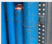
Catene di sicurezza per fissaggio bombole
