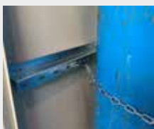
Catene di sicurezza per fissaggio bombole
